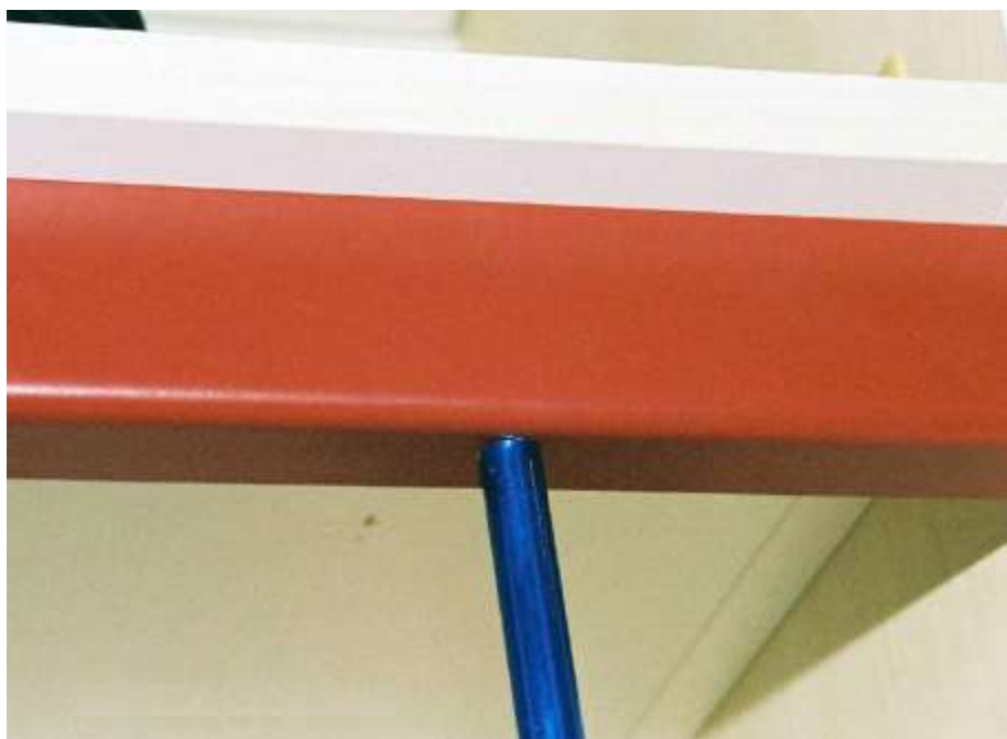
Bild 12.2. Anschrauben einer Lichtblende
