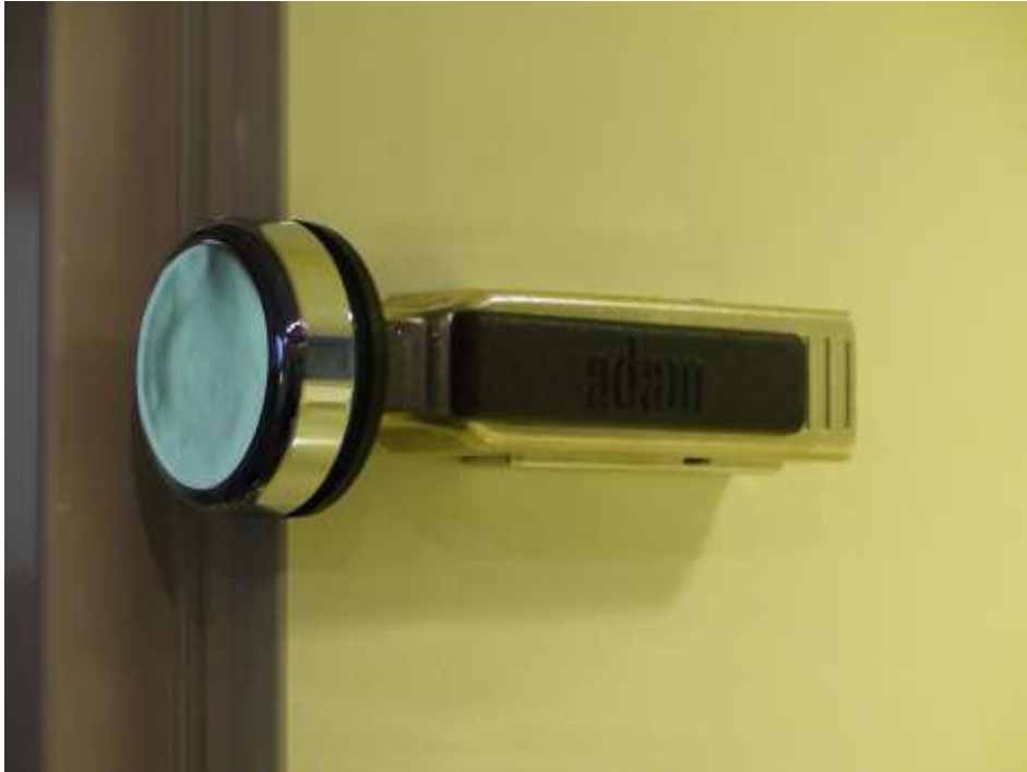
Bild 16. Montiertes Gelenkband an Vollglastür.
