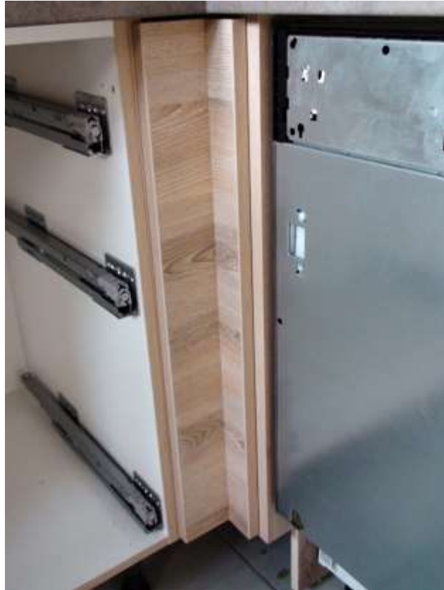
Bild 6. Einbau Eckpaßstück.
