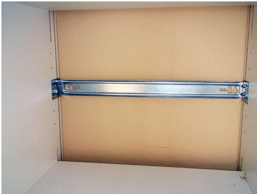
Bild 26. Montageschiene für Geräteumbauschrank.
