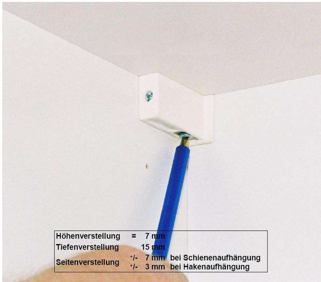
Bild 11.2. Höhenverstellung für Oberschrankschrankaufhänger.
