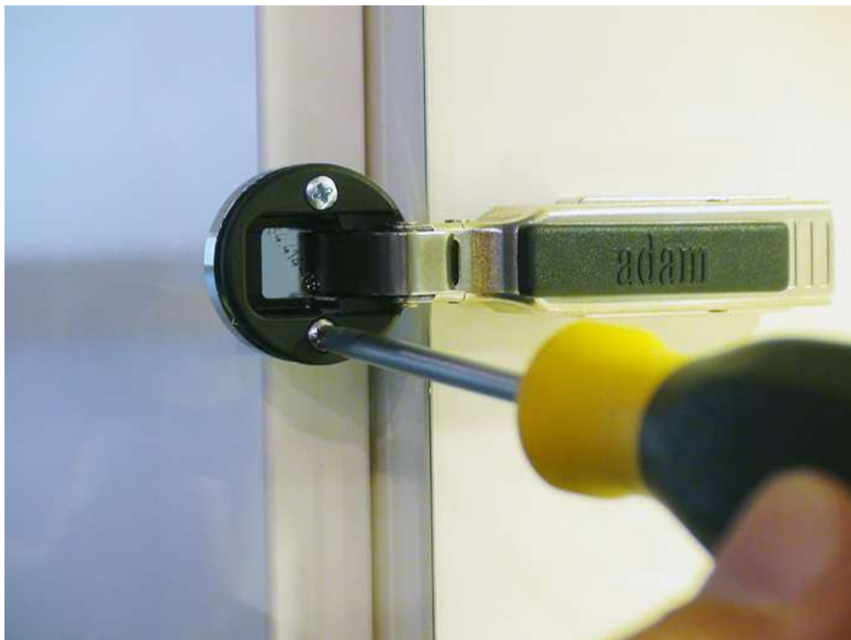
Bild 15. Abdeckkappe an Gelenkbändern für Vollglastüren verschrauben
